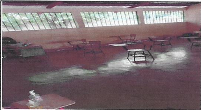
Foto 3: Sustitución de piso de torta de concreto a piso cerámico
