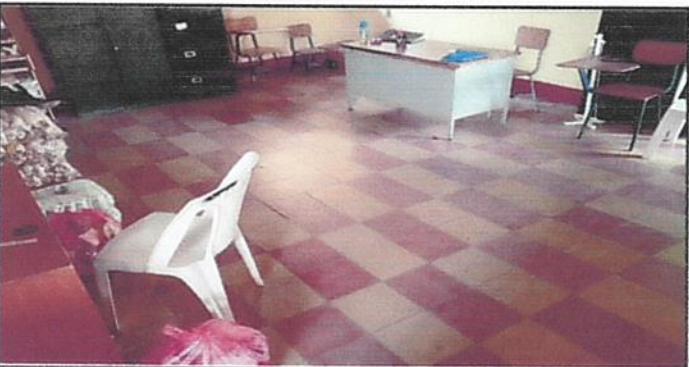
Foto 5: Sustitución de piso de torta de concreto a piso cerámico
